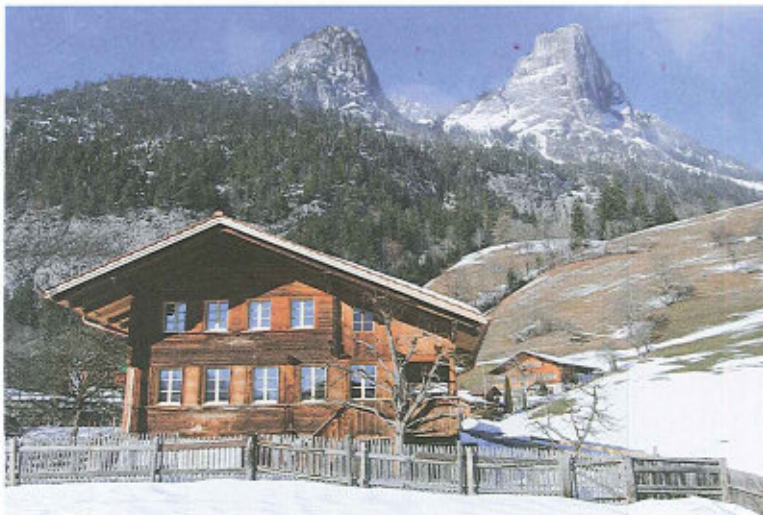
8 Das Holzhaus in Boltigen wurde behutsam saniert. | The timber house in Boltigen has been carefully restored.
