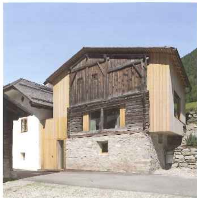
Der Widum und der später angeschlossene Stall vor der Sanierung (oben). Die marode Fassade wurde abgenommen und wie ein Bild als Spolie vor das Nebenhaus montiert.
