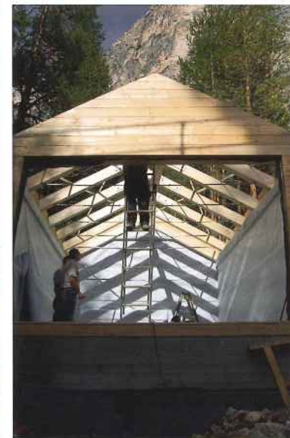
A sinistra, sul fondo, la predisposizione del locale bagno; a destra, la struttura portante del tetto.
